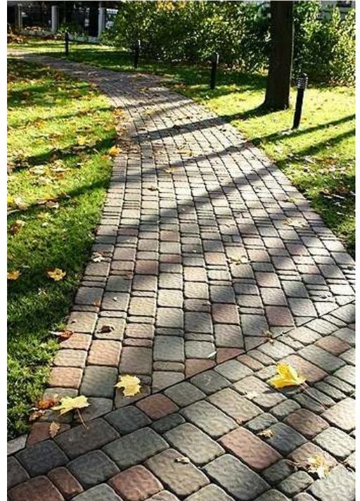
Projektā paredzētas četras 3,5m platas nobrauktuves un viena 6m plata nobrauktuve. Nobrauktuves izbūvē no tāda paša betona bruģakmens kā ietves, bet ar h=8cm.
