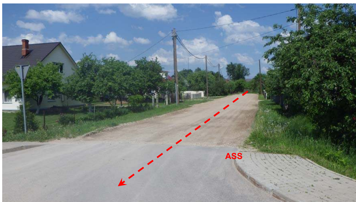
4.attēls.Liepājas iela PK 3+36.50 (skats trases sākuma virzienā).
