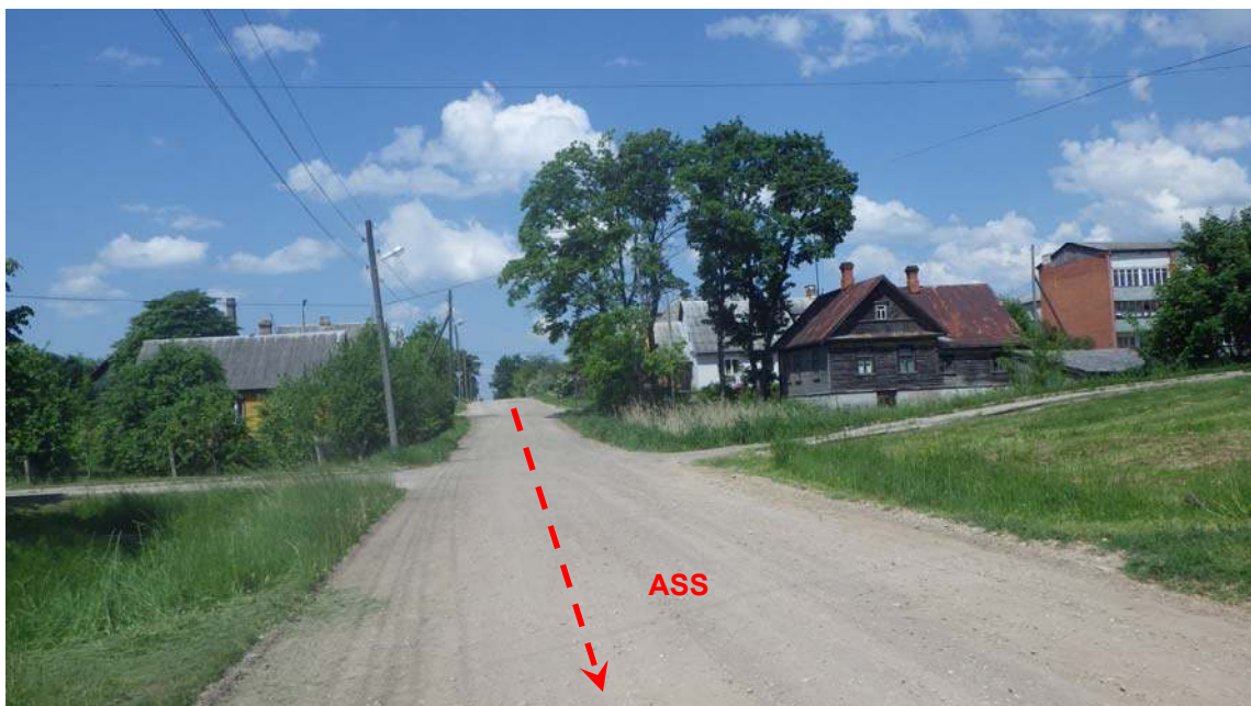
2.attēls. Liepājas iela PK 0+90.00 (skats uz trases sākumu).
