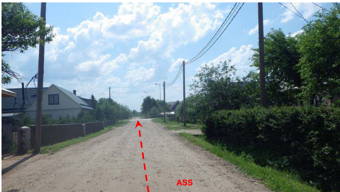
3.attēls. Liepājas iela PK 2+70.00.
