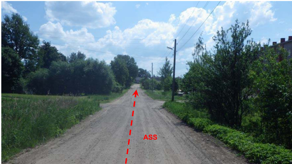
1.attēls. Liepājas iela PK 0+10.00.
